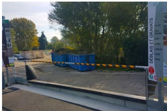
**Spécifique GRAVATS : BAVETTE + LISSE DE SÉCURITÉ EN ALU** permet de gérer le vidage dans le caisson à gravats en toute sécurité et en conformité à la norme : hauteur de chute < 1m avec rehausseur.
